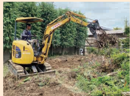
長野市豊野地区の解体予定の家屋で木の伐根作業
